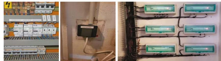
Reprise alimentation des caissons VMC et des système de sécurité (DSC)
